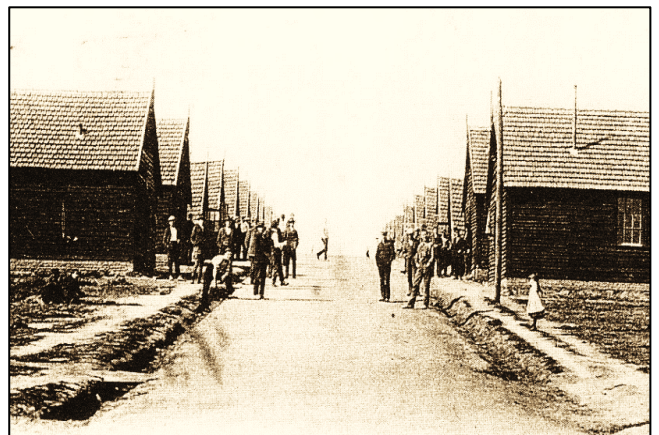
Le "camp polonais" de à MARLES-LES-MINES au début des années 20 : ce sont baraquements en bois construits pour ne recevoir que quelques centaines de Polonais. La Compagnie des Mines de MARLES devra ensuite construire d'immenses cités minières pour en accueillir des milliers. Photo D. MUSART
